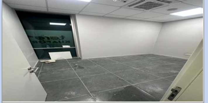
4A-5A BLOK ZEMİN KAT OFİS TADİLATI İŞİ
