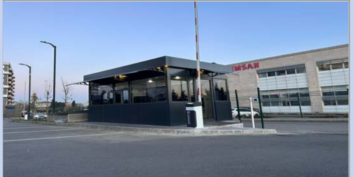
KUZİY NİZAMİYE GÜVENLİK KULUBESİ YAPIM VE ÇEVRE DÜZENLEME
