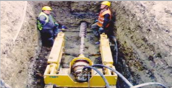
ANADOLU (178) DOĞALGAZ BORU HATTI PROJESİ
