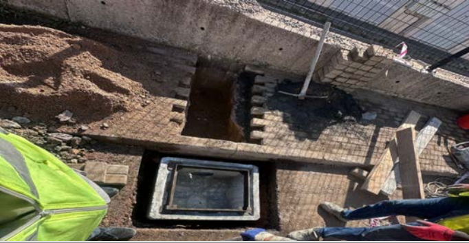
KUZİY NİZAMİYE OTOPARKI YAĞMUR SUYU İŞİ
