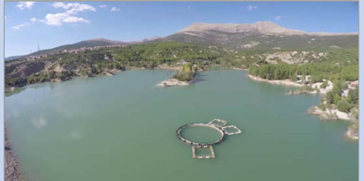
ISPARTA/GÖNEN GÜNEYKENT GÖLETİ VE SULAMA İNŞAATI
