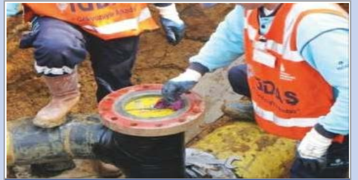
ANADOLU (55) PE VE SH ALT YAPI İNŞAATI
