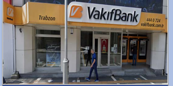
VAKIFBANK TRABZON ŞUBE 2. TADİLAT VE DEKORASYON İNŞAATI
