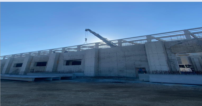
ERTUĞ METAL 1. ETAP FABRİKA YAPIM İŞİ
