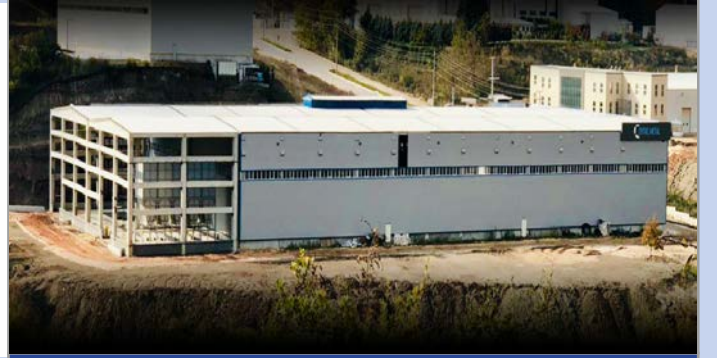
ERTUĞ METAL 2. ETAP FABRİKA YAPIM İŞİ
