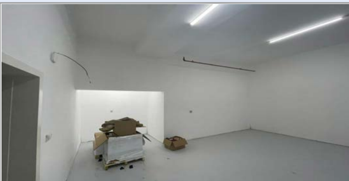
SMW AUTOBLOK DEPOLAMA ALANI YAPIM İŞİ
