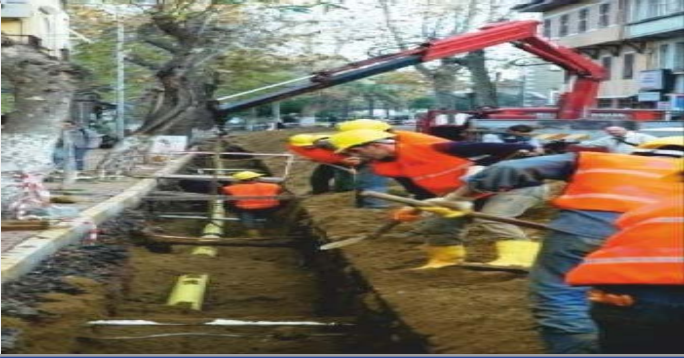
ANADOLU (44) PE VE SH ALT YAPI İNŞAATI
