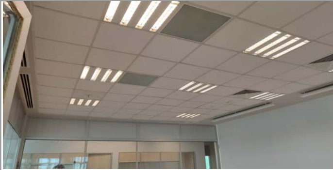
5. BLOK 2. KAT OFİS TADİLATI İŞİ
