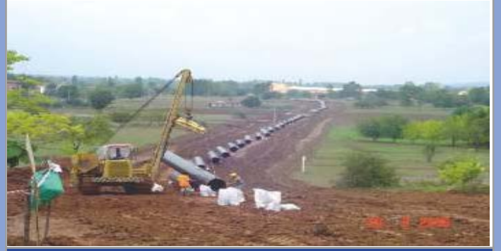
ANADOLU (147) ST, PE, SH DOĞALGAZ BORU HATTI PROJESİ
