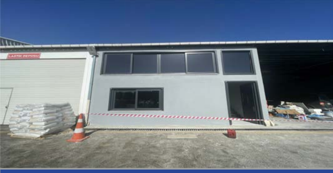
ANADOLU YAKASI 2 KATLI ÇELİK TAŞIYICI SİSTEMLİ OFİS YAPIM İŞİ
