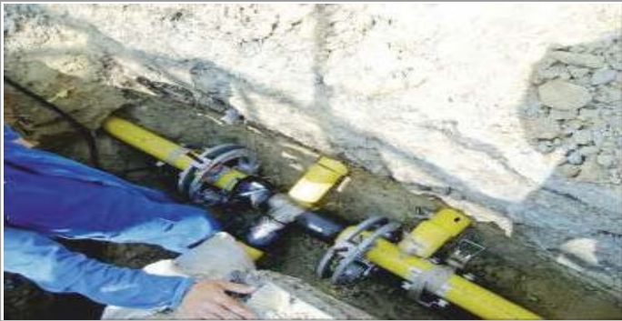
İSTANBUL & BOĞAZİÇİ (162) DOĞALGAZ BORU HATTI PROJESİ
